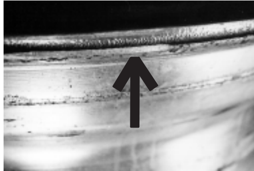
Kuva 9. Kun vannelaipan kulumisesta aiheutunutta terävää reunaa tasoitetaan, niin siitä poistetaan vain se määrä metallia, mitä reunan tasoittamiseksi tarvitaan.
